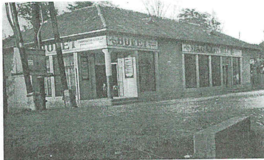
Localul cooperativei. Construit 1961
