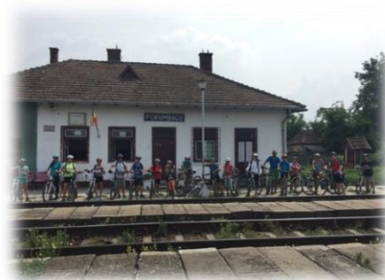
Foto nr. 11 - Stația Porumbacu de Jos
